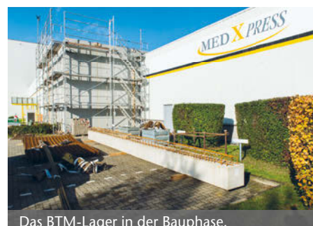
Das BTM-Lager in der Bauphase.
