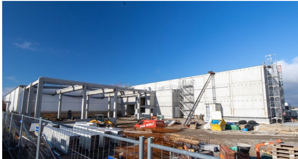
In Verbindung mit dem BtM-Lager entsteht auch eine Be- und Entladehalle (links)
