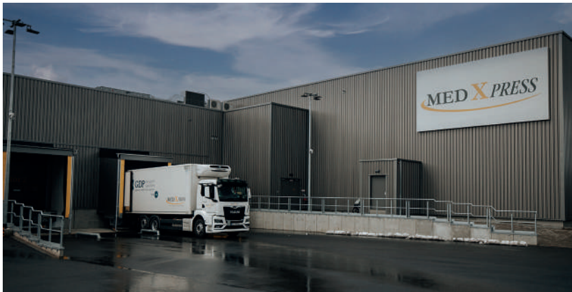
Abbildung 1: Außenansicht des BtM-Lagers (rechts) mit der Be- und Entladehalle (Quelle aller Abbildungen: Med-X-Press GmbH).
